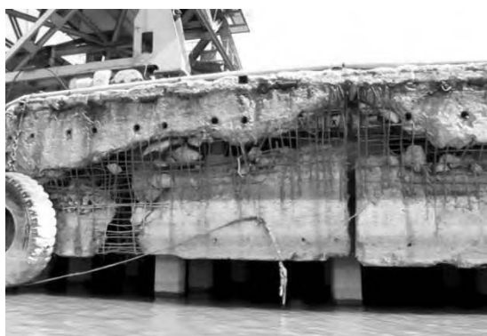
Рис. 2. Состояние бортовой балки
