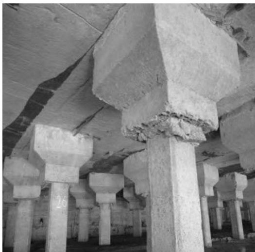
Рис. 1. Состояние сваи и наголовника
