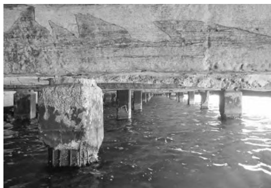
Рис. 3. Повреждения свайного основания
