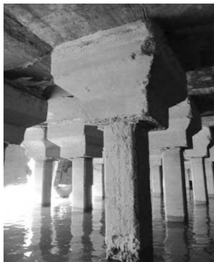
Рис. 1. Состояние сваи и наголовника
