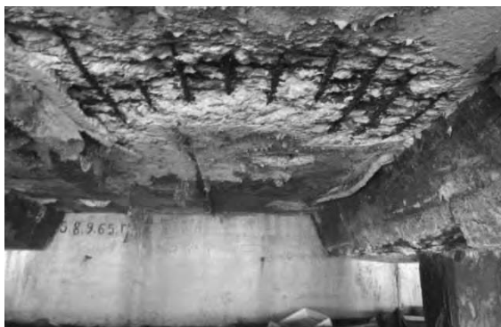
Рис. 4. Состояние нижней поверхности плиты ростверка и наголовников свай
