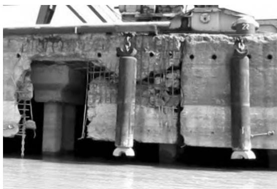
Рис. 2. Состояние бортовой балки
