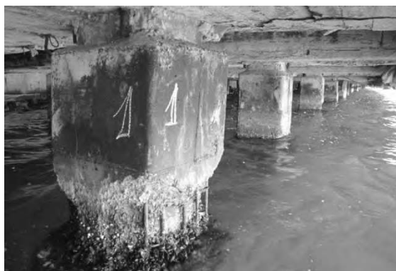
Рис. 3. Повреждения свайного основания
