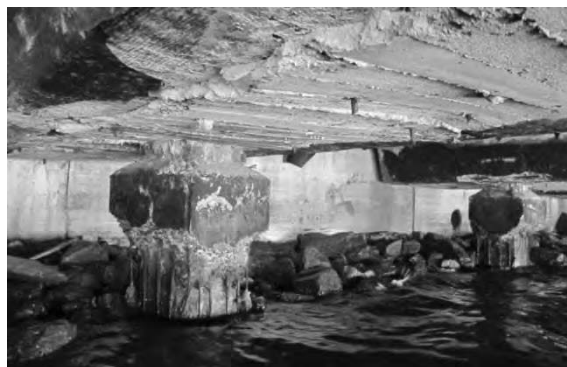
Рис. 4. Состояние нижней поверхности плиты ростверка и наголовников свай
